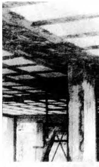
Εικ. 208 Μόνωση πλακών με διογκωμένη πολυστερίνη.
