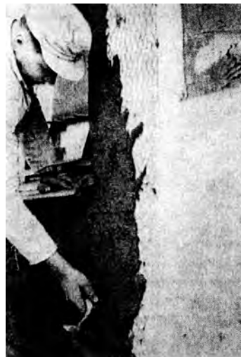
Εικ. 211 Εφαρμογή θερμομονωτικού σοβά.
